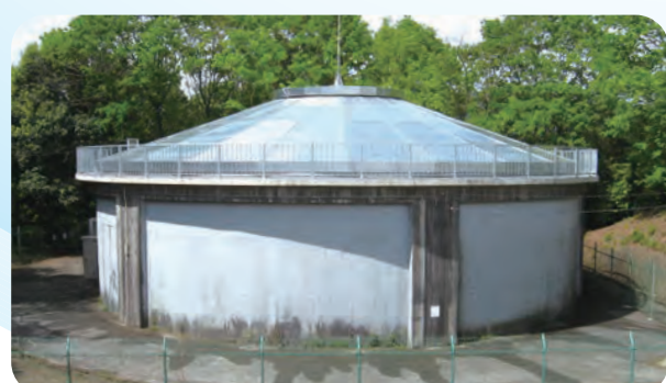
⑦ 生駒市東生駒配水池
