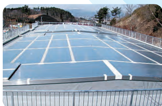
⑥ 福島市清水町配水池
