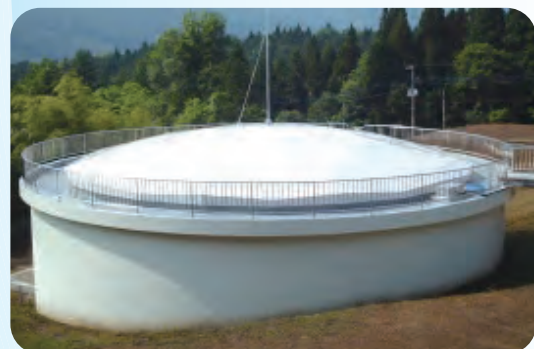
④ 日光市安良沢配水池
