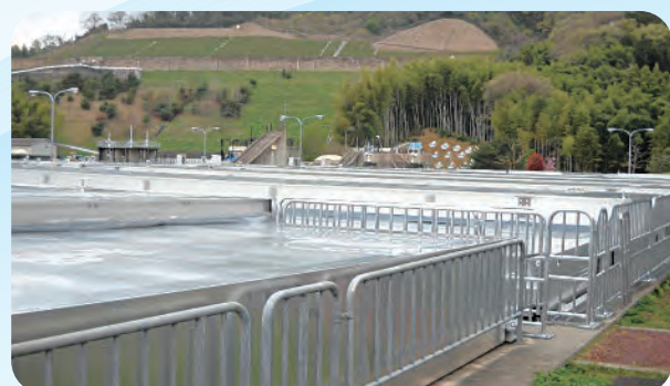
⑬ 京都市新山科浄水場沈殿池
