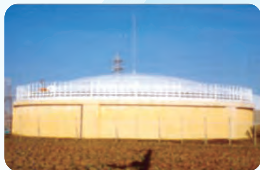
② 銚子市上野町配水池
