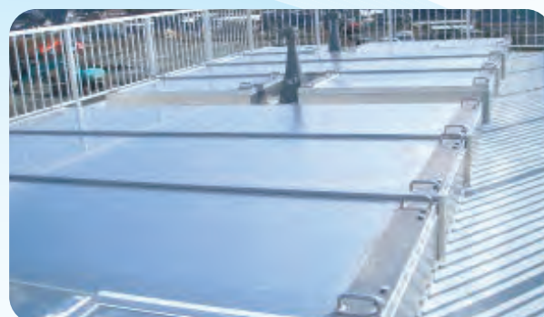
⑮ 八戸圏域水道企業団着水井
