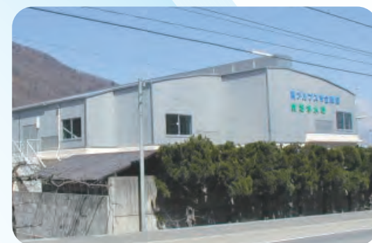
⑬ 南アルプス市沈殿池
