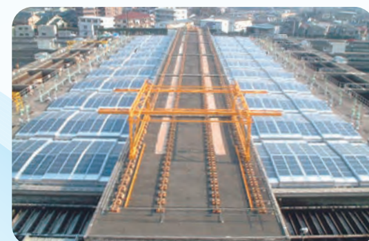
⑭ 東京都朝霞浄水場急速ろ過池
