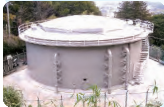
⑤ 横須賀市阿部倉配水池
