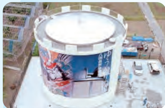
③ 南アルプス市八田配水池
