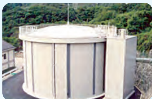
① 神戸市新烏原調整池
