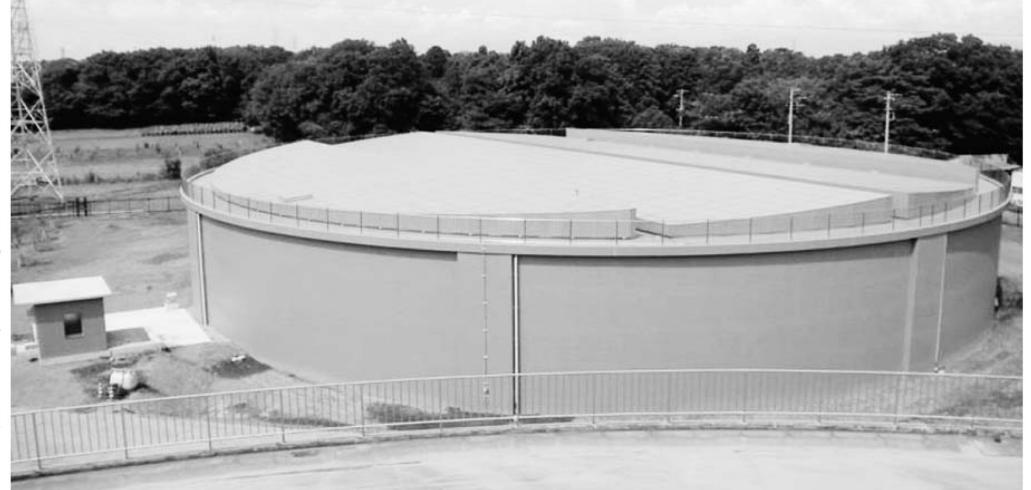
アルミ覆蓋により完成した6号送水調整池
