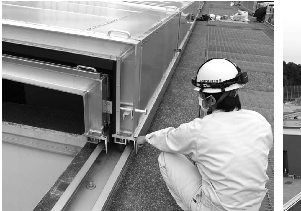
レールが設置されていてスムーズな開閉が可能
