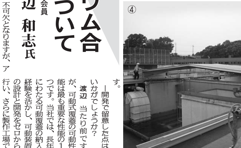
平成29年度には4系のうち2系(右側)で覆蓋工事が完成
