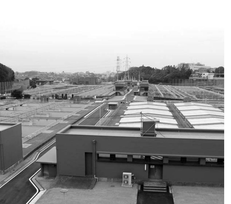
平成29年度には4系のうち2系(右側)で覆蓋工事が完成
