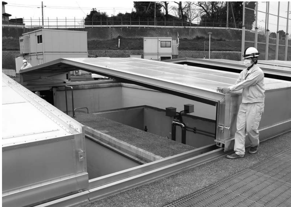
両側に1人ずつ配置すると15kgの力で開閉可能
