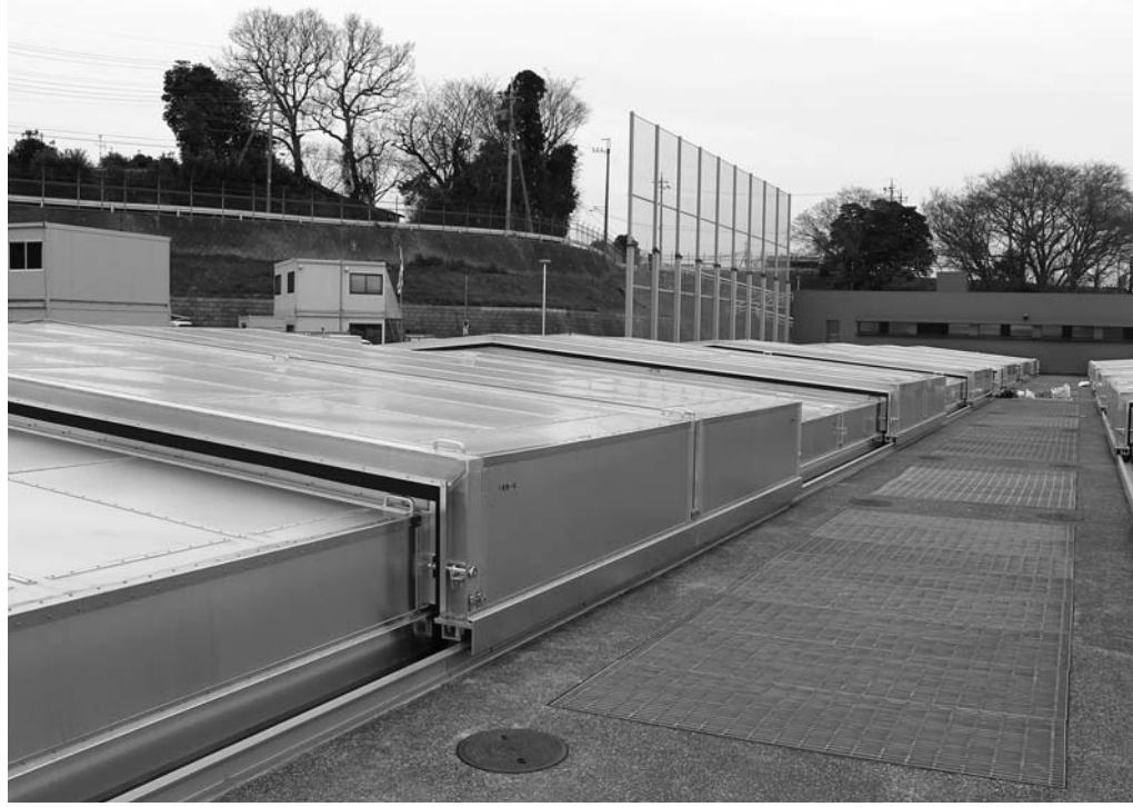
ろ過池への覆蓋設置面積は4系で約7400㎡
